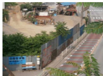
永田橋西側の狭い歩道
