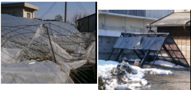
大雪で倒壊したビニールハウス・カーポート
