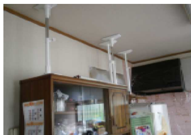
室内に設置された家具転倒防止器具
