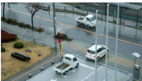
危険一杯の市役所出入口
