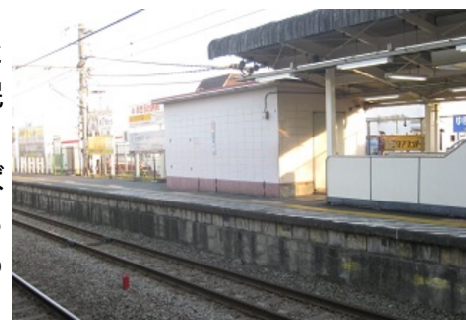
秋川駅下りホーム エスカレーター付近
