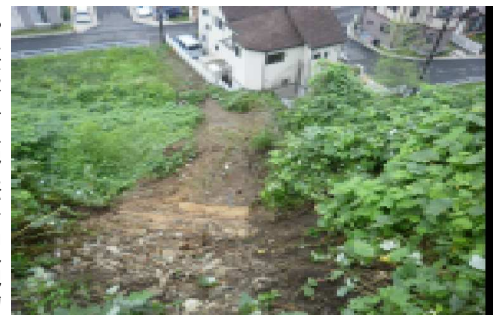
草花、折立地区がけ崩れ現場
