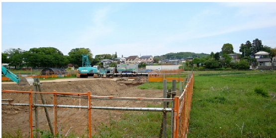
高瀬地区の田んぼに秋3.3.9号線の橋をつくる橋脚現場
